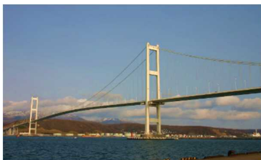
【東日本最大の吊橋：白鳥大橋】
