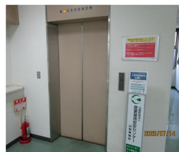
1階エレベータで5階へ……
