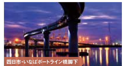
四日市・いなばボートライン橋脚下
